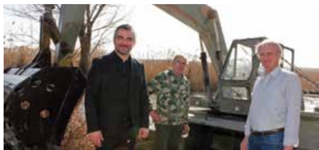
Landesrat Heinrich Dorner und Bürgermeister Erwin Preiner nahmen vor Ort den Einsatz des Schwimmbaggers und die Pflegemaßnahmen in Augenschein Foto: Gemeinde Winden
